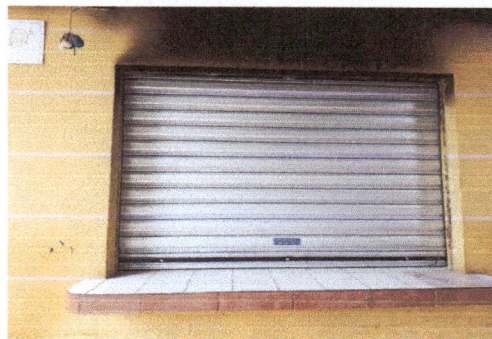
Foto 8: MODULO 7: SUSTITUCIÓN DE VENTANA DE METAL POR PERSIANA DE ALUMINIO.
