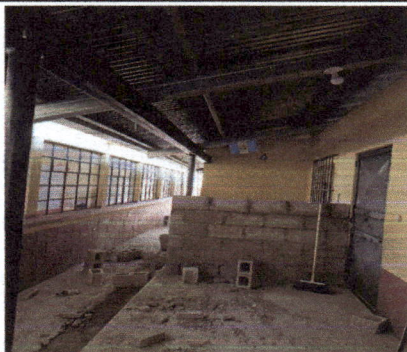
Foto 3: MODULO 2: MEJORAMIENTO Y SEGUIMIENTO PAREDES DE LA DIRECCION
