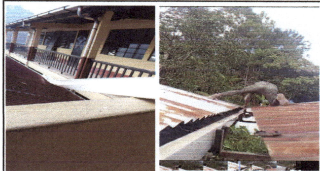
Foto 4: MODULO 3: SUSTITUCION DE CANAL DE METAL POR CANAL PLUVIAL DE PVC
