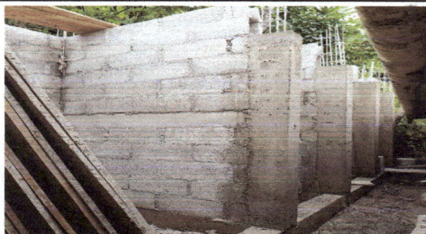
Foto 5: MODULO 4: SEGUIMIENTO DE MÓDULO DE BAÑO
